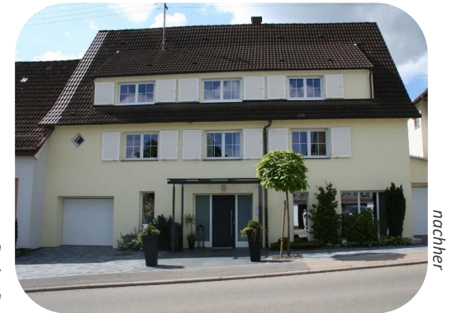
Beispielfotos einer erfolgreichen Sanierungsmaßnahme: Dettenseer Straße 25 in Empfingen
