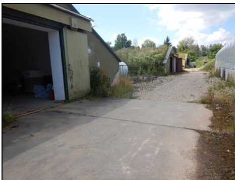
Nördliche Bunkerreihe, Folienhaus rechts, Blick in Richtung Westen
