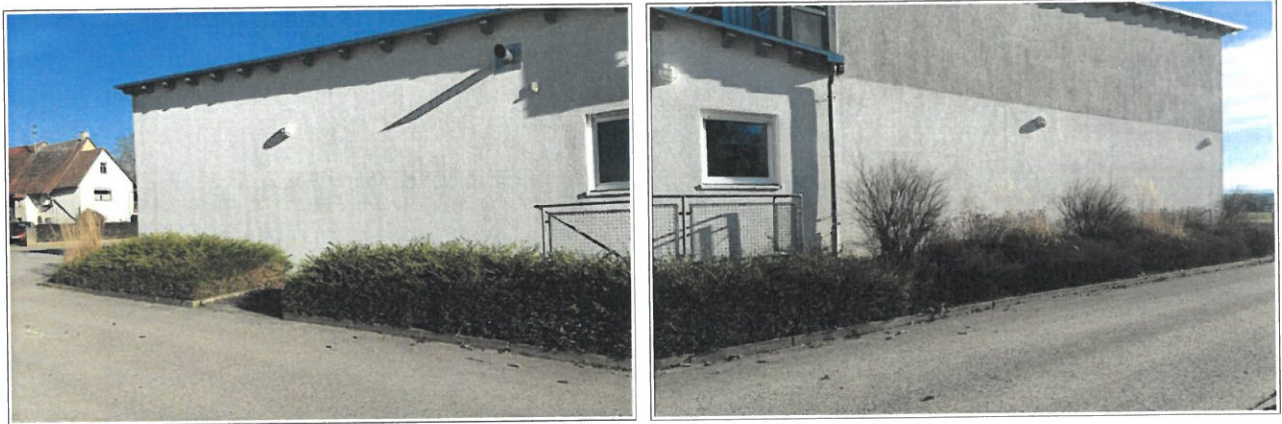
Abb. 9+10: Westfassade des Dorfgemeinschaftshauses ohne Spuren auf eine Nutzung durch planungsrelevante Arten.
