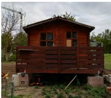
Abb. 19: Gartenhäuschen im Nordwesten
