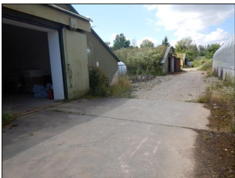
Nördliche Bunkerreihe, Folienhaus rechts, Blick in Richtung Westen
