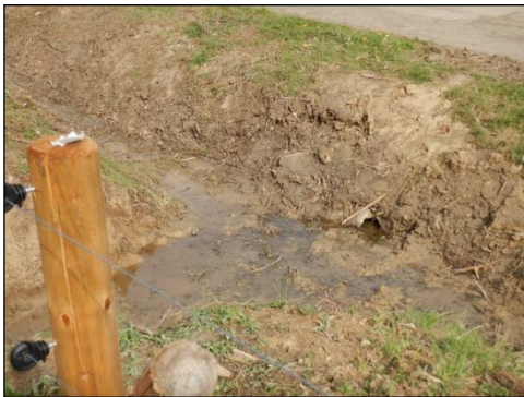
Wasserführender Graben mit wenig bis zum Teil viel Bewuchs
