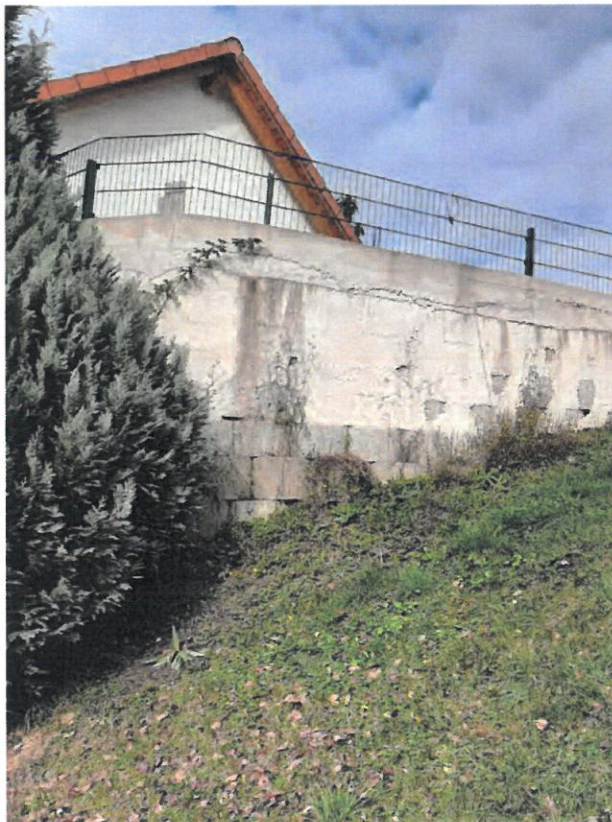
Abb. 5: Stützmauer am Rand des Plangebiets
